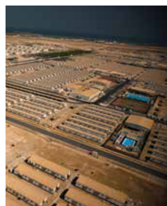
DIE PEARL GTL-ANLAGE IN KATAR
