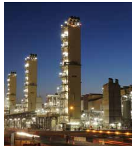
DIE PEARL GTL-ANLAGE IN KATAR
